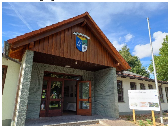
Abb. 8: Eingangsbereich des DGH
